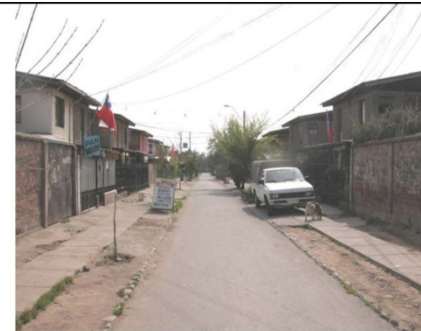
Avenida El Tamarindo current condition
